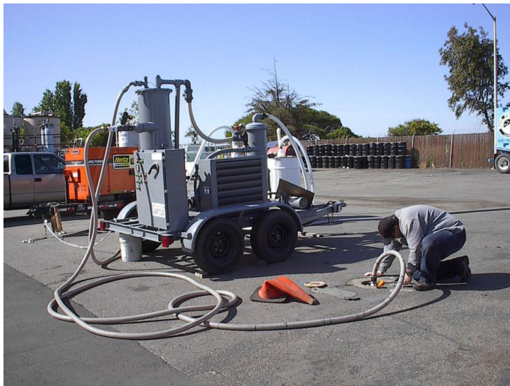
ภาพที่ 6 การขุดและฉีด (inject) สารออกซิเจนลงไปใน subsurface
