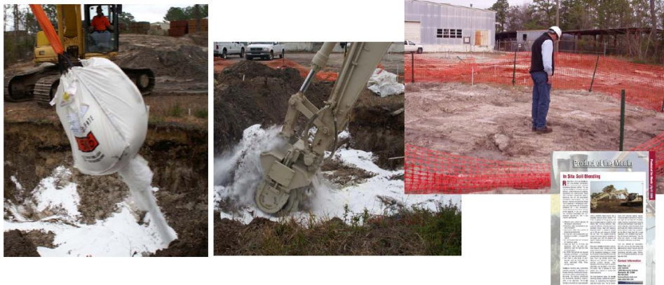
ภาพที่ 5 การฟื้นฟูดินปนเปื้อนโดยใช้ sodium persulfate
