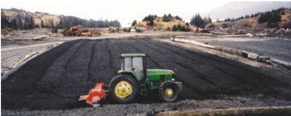
ภาพที่ 10 กระบวนการ Landfarming ในการฟื้นฟูดินที่ปนเปื้อน ที่มา: http://www.etecllc.com/landfarming-bioremediation.asp
